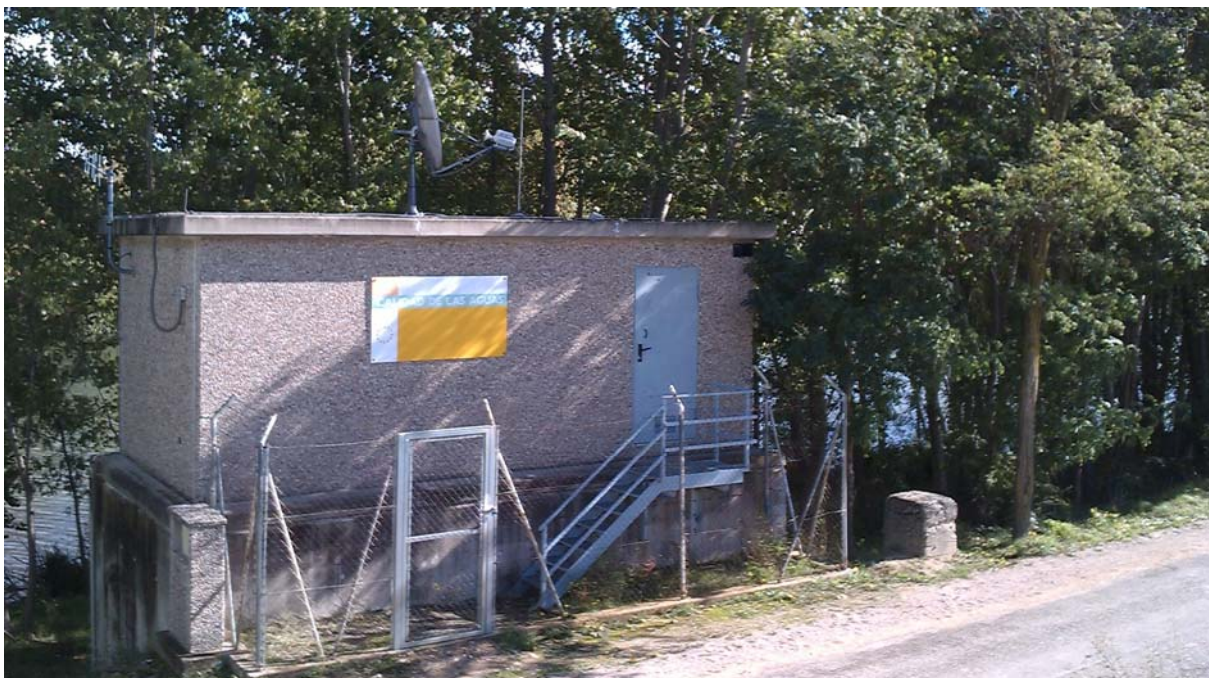
Estación de alerta "Ebro en Haro". Vista exterior.
