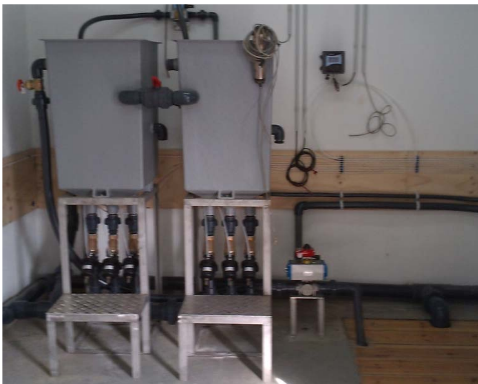
Estación de alerta "Ebro en Miranda". Zona de decantadores tras la reforma.
