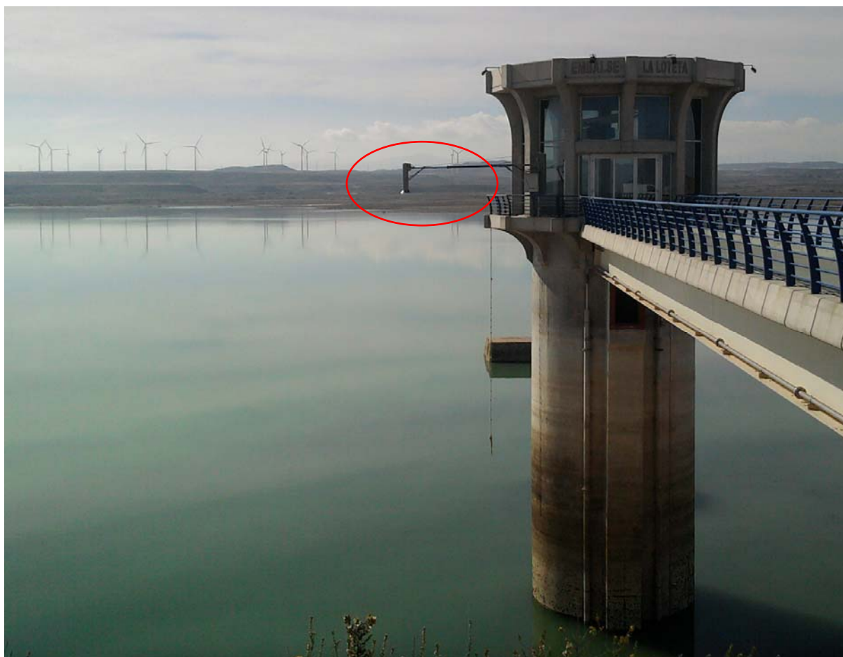
Vista de la sonda Aquadam instalada en el embalse de La Loteta
