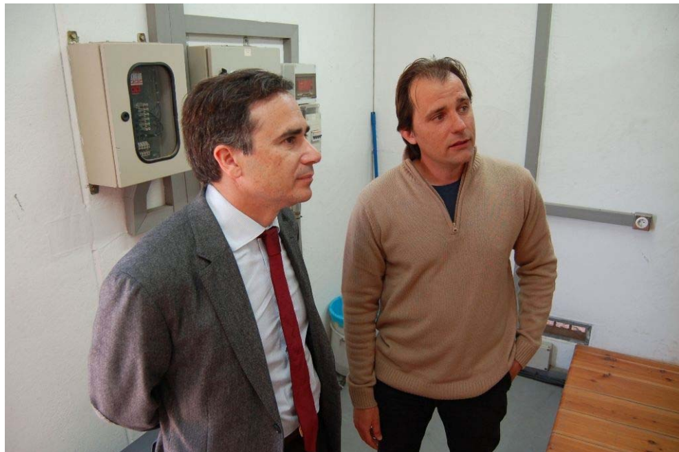
Abril de 2012. Visita del presidente de la CHE, D. Xavier de Pedro, a la estación de alerta del río Ebro en Ascó
