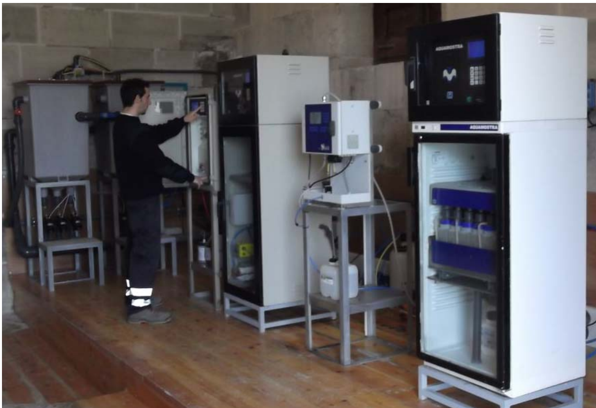
Estación "Ebro en Pignatelli-El Bocal". Técnico realizando trabajos de mantenimiento.
