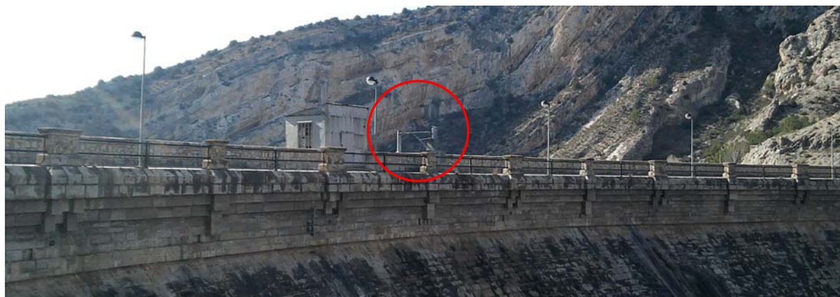
Vista de la sonda Aquadam instalada en la Presa de Cueva Foradada
