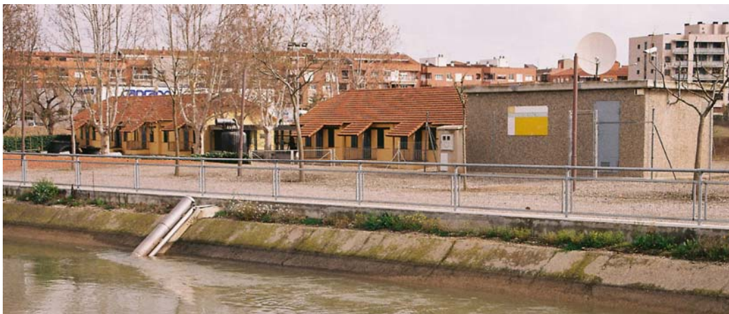
Estación de alerta "Canal de Serós en Lleida"
