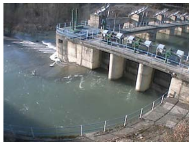
Fotografía recogida en la estación 904 – Gállego en Jabarrella
