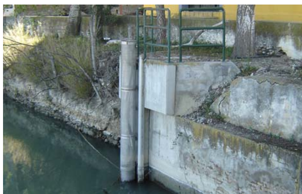
Estructura de captación del agua
