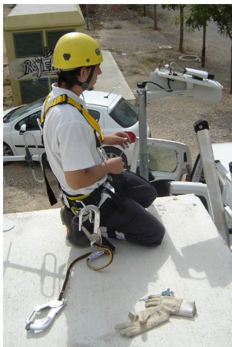
Tareas de mantenimiento en cámara instalada en el tejado
