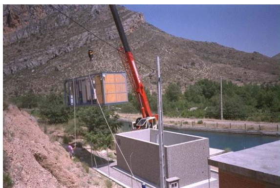
Fase de montaje
